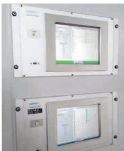
Реализация централизованных защит на базе процессоров Intel и Эльбрус
