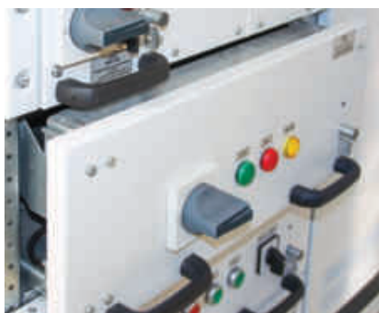
Защита от прикосновения в тестовом режиме
